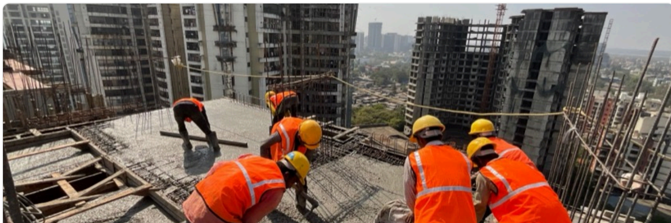
Hochhausdecken Konstruktionsbetonagen und Estriche für Hochhausgeschosse.
