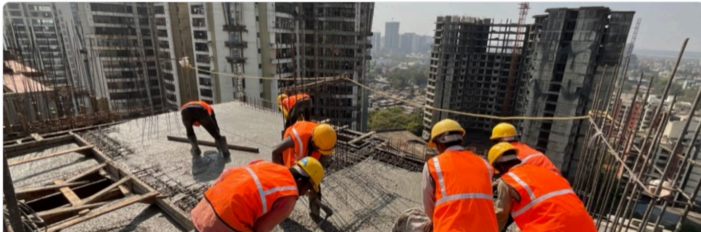
Planchers de grande hauteur Coulages structuraux et chapes pour étages de grande hauteur.
