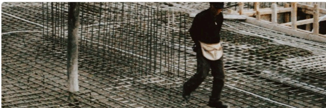
Armature et étanchéité Systèmes d'étanchéité appliqués avant le coulage.
