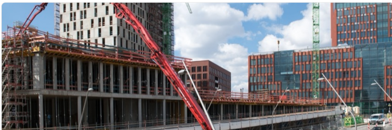
Układanie betonu Dostawa betonu towarowego i układanie za pomocą pompy na budowie.
