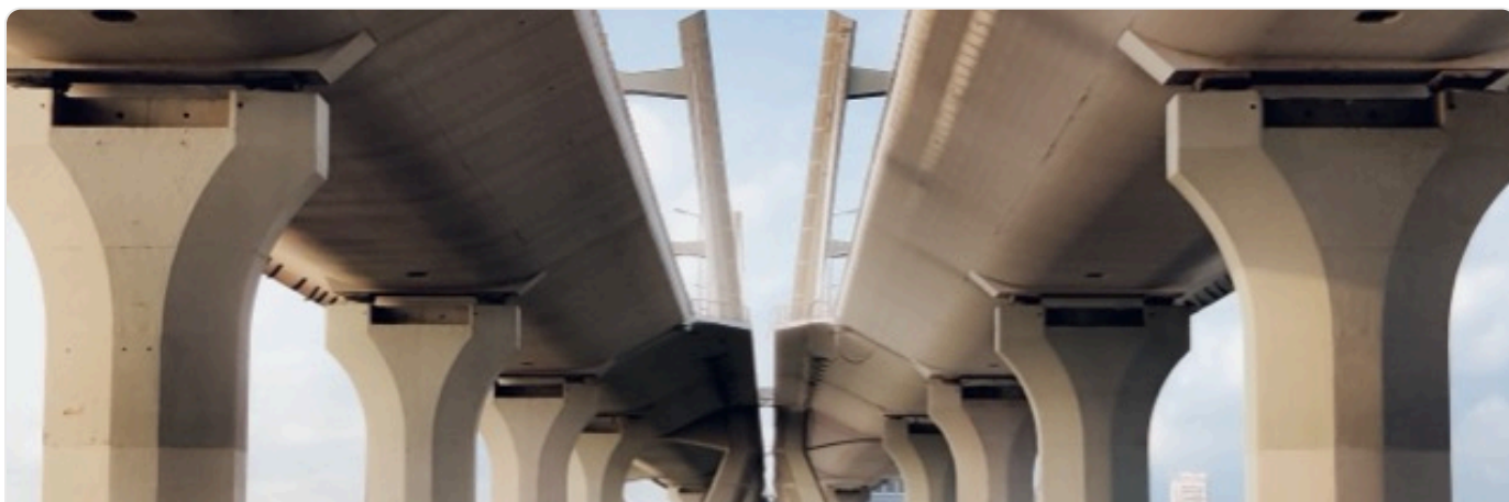
Инфраструктура Долговечный бетон и защитные покрытия для мостов.
