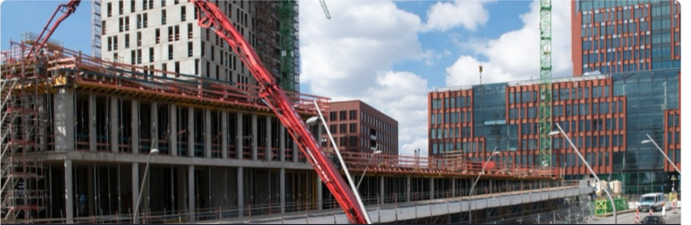
Beton Yerleştirme Şantiyede hazır beton teslimatı ve pompayla yerleştirme.
