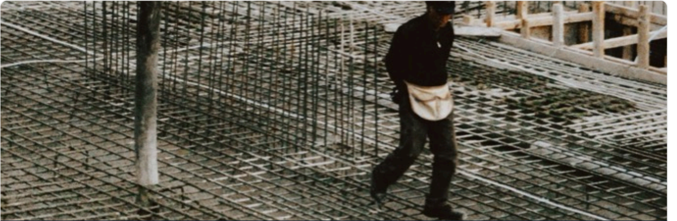
Donatı ve Su Yalıtımı Döküm öncesinde uygulanan su yalıtım sistemleri.
