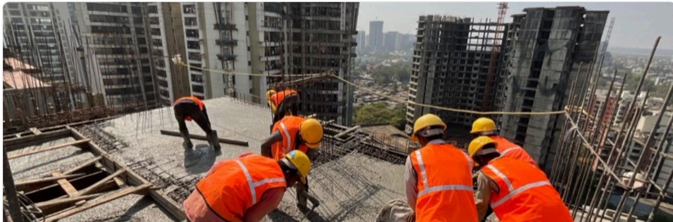
Перекриття висотних будівель Конструкційні заливання та стяжки для поверхів висотних будівель.
